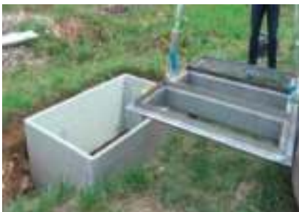
4. Déposer le cadre sur la structure de la chambre à l'aide d'élingues.
