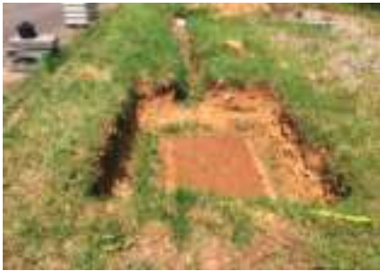
1. S'assurer d'un terrassement stable et de niveau.
