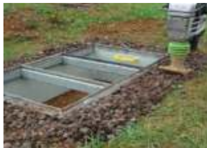
5. Remblayer, compacter à l'aide d'une dameuse, à fleur de cadre.
