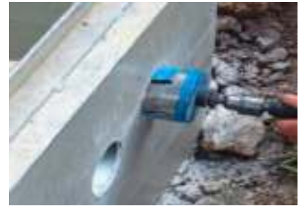
3. Percer les couronnes à l'aide d'une scie cloche pour les raccordements. (Ne pas percer la première couronne).
