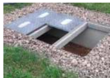
6. Les couvercles PRV sont déposés sur le cadre à l'aide de cannes de levage.
