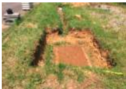
1. S'assurer d'un terrassement stable et de niveau.
