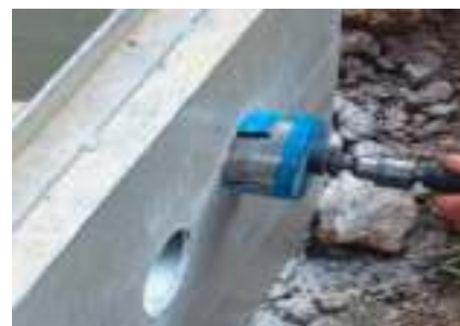
3. Percer les couronnes à l'aide d'une scie cloche pour les raccordements. (Ne pas percer la première couronne )
