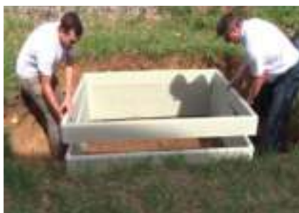
2. Poser la première section et vérifier son niveau. Puis emboîter une à une les couronnes suivantes.
