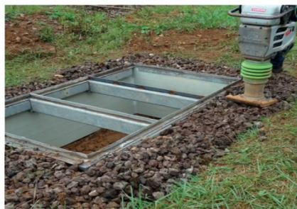
5. Die Baugrube bündig bis zur Oberkante des Stahlrahmens auffüllen und mit einem Vibrationsstamper verdichten.
