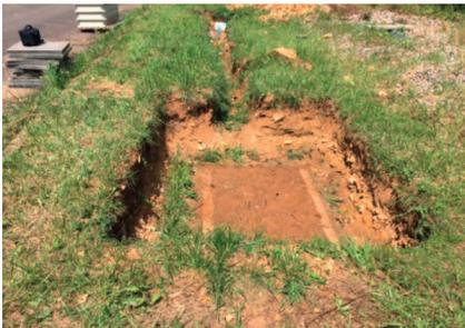
1. Nach dem Ausheben der Baugrube ist eine, unter Berücksichtigung der Bodenverhältnisse, ebene, trag- und sickerfähige Baugrubensohle zu erstellen.
